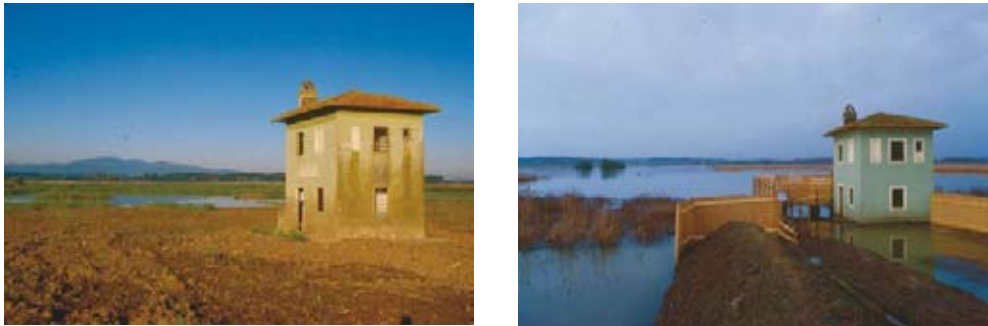
Figura 2.13. Il Casotto del Biagiotti, prima e dopo gli interventi di restauro. Oggi la struttura è adibita ad osservatorio faunistico. (Foto E. Zarri, A. Bartolini)
