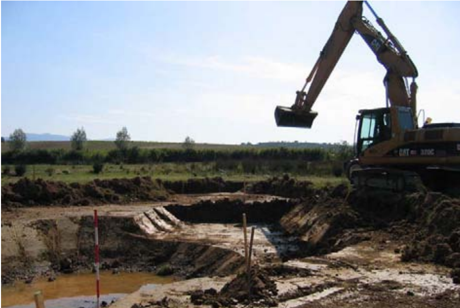
Figura 4.8. Le operazioni di scavo di uno stagno destinato prioritariamente alla conservazione delle piante acquatiche (Loc. Rio di Bagnolo, area contigua della riserva naturale). Procedendo per gradoni concentrici di ampiezza sempre maggiore è possibile ottenere condizioni favorevoli per piante che radicano a profondità diverse. (Foto A. Bartolini)
