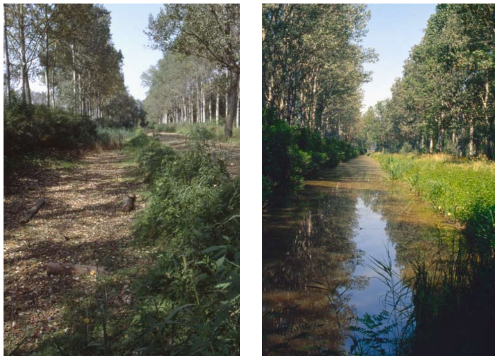
Figura 4.14. Il canale lungo il viale d'ingresso dell'area Righetti prima e dopo l'intervento di ricavatura e di riprofilatura delle sponde. (Foto A. Bartolini)
