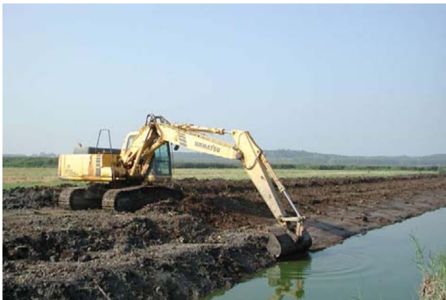
Figura 4.12. Riprofilatura della sponda sinistra del Fosso Pancioli (area Le Morette). (Foto E. Zari)
