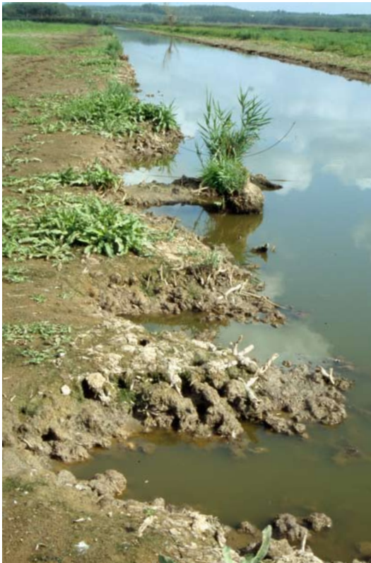
Figura 4.20. Erosione della sponda di un canale a causa dell'azione combinata di Nutria e Gambero rosso della Louisiana. (Foto A. Bartolini)
