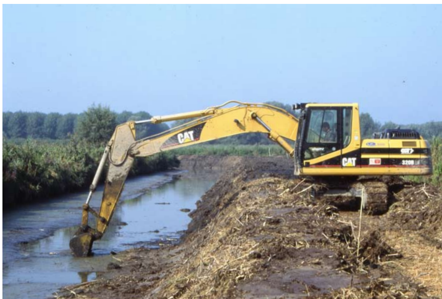
Figura 2.9. Operazione di “ripascimento” degli argini nell’area Le Morette per il ripristino del sottobacino. (Foto A. Bartolini)
