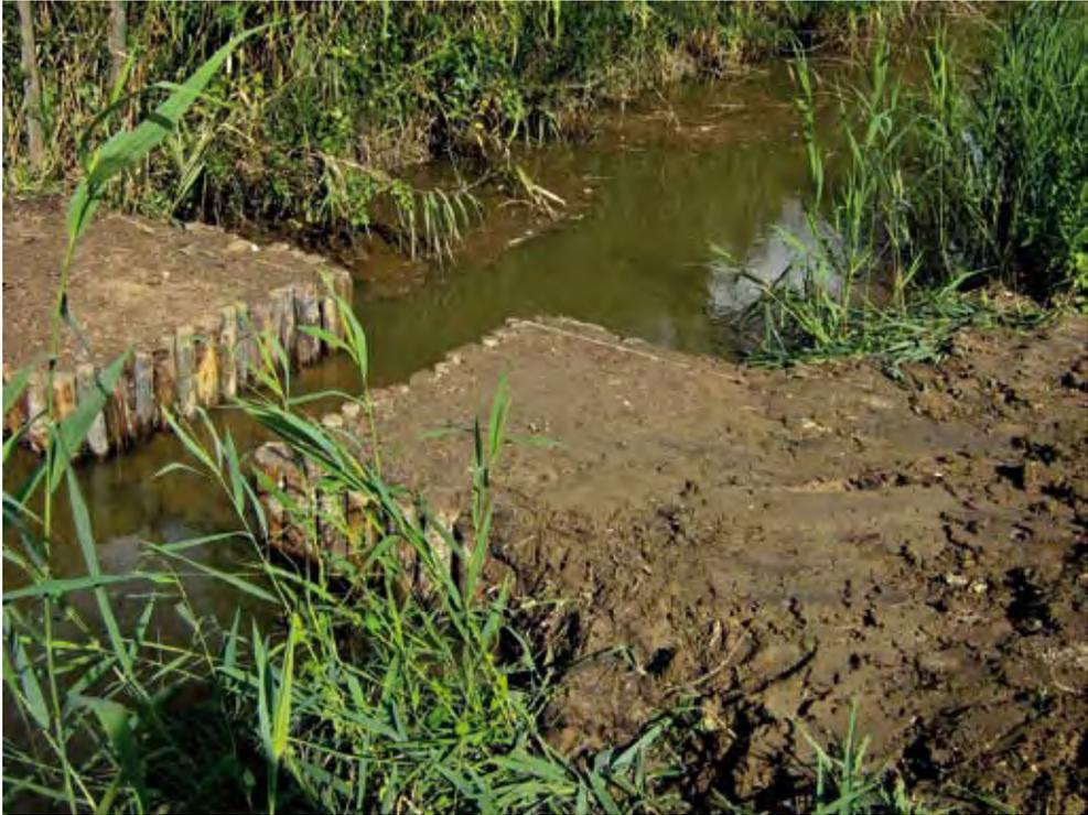
Una traversa realizzata in ingegneria naturalistica immediatamente a valle della presa dell'acqua per alimentare la superficie arginata (area Il Pratone). L'inserimento nelle guide di una paratoia consente di innalzare il livelli del corso d'acqua allo scopo di alimentare l'area palustre ripristinata. Foto A. Bartolini.
